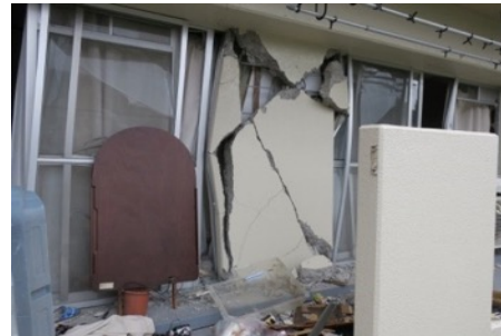
熊本地震における非構造壁の損傷
