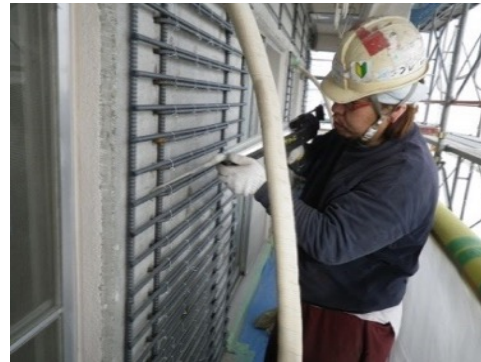
PCM施工例 (サイド・ポ・スト工法)
