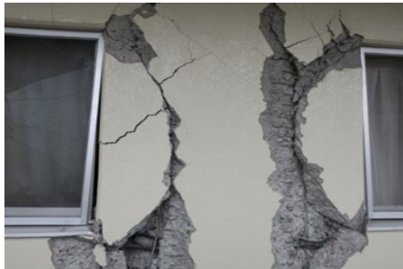
熊本地震における非構造壁の損傷
