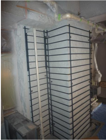
補強鉄筋取付
