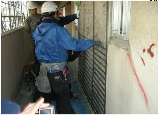
補強鉄筋取付
