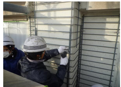
補強鉄筋取付
