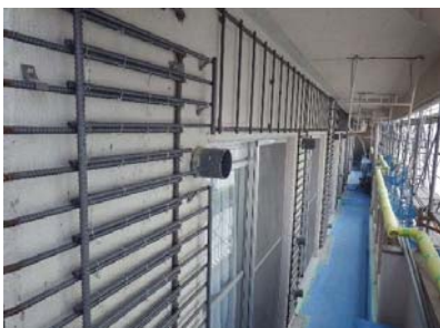
補強鉄筋取り付け
