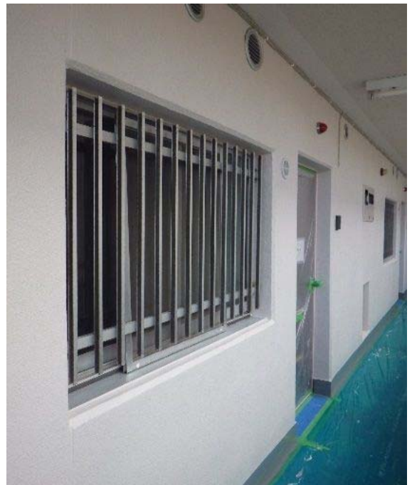
内廊下(補強後)
