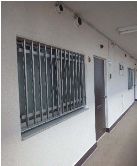
内廊下(補強前)
